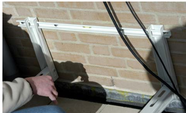
28. Schuif de draagarmen over de muurrail.
