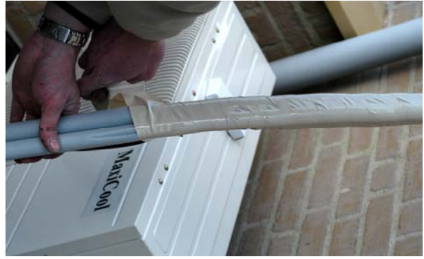
34. Omwikkel de koelleidingen met condensslang en elektro-kabels zodat het een geheel vormt. Knel de condensslang niet af !
