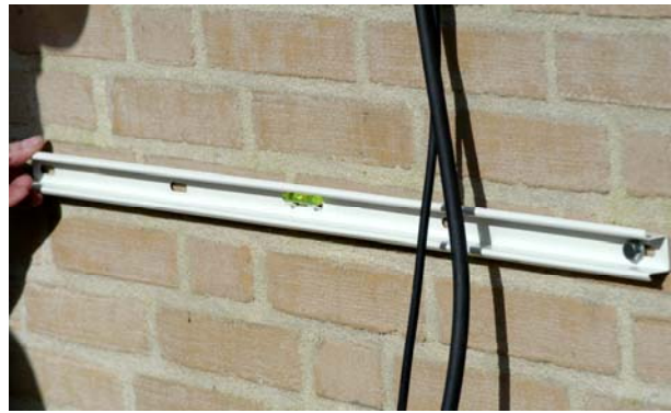
26. Monteer de optioneel verkrijgbare muurbeugel waterpas aan de muur met de bijgeleverde pluggen.
