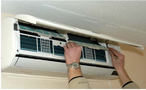
45. Breng de filters aan in de binnen-unit.
