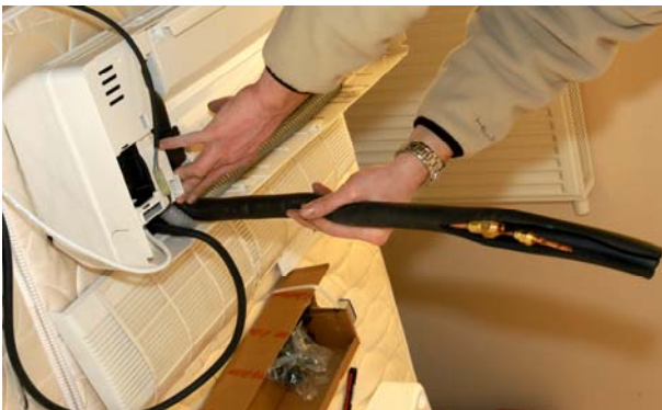
21. Buig de koelleiding voorzichtig in de juiste stand. Maak een bundel van de koelleiding met de electrokabels.
