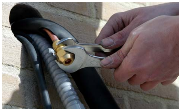
30. Verwijder de beschermdoppen van de koelleidingen. U hoort een sissend geluid van het vrijkomende conserveergas. Dit is normaal en ongevaarlijk.
