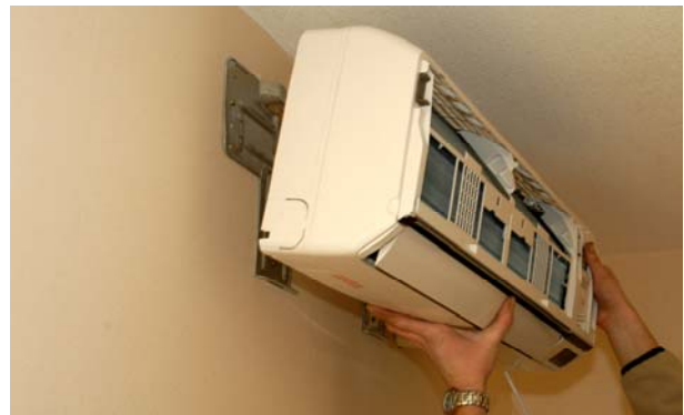
22. Voer de complete bundel door het gat naar buiten en hang de binnenunit aan de bovenkant op de lippen van de montageplaat.
