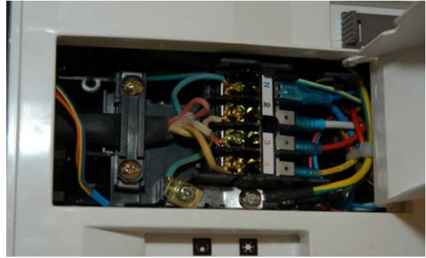
18. Monteer de vijfaderige kabel conform de kleurcode op het paneel. Leg de kabel onder de trekplaster en monteer dit goed vast.
