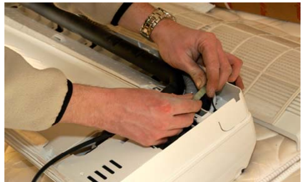
20. Klik de bijgevoegde 2 aderige signaalkabel in de adapter aan de achterzijde van de binnen-unit.
