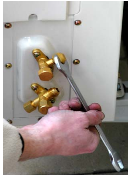
36. Verwijder de kunststof beschermkappen van de ventielen.
