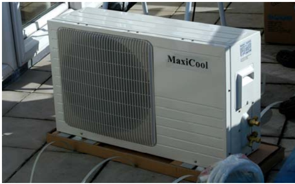
25. De buiten-unit is nu klaar voor montage.
