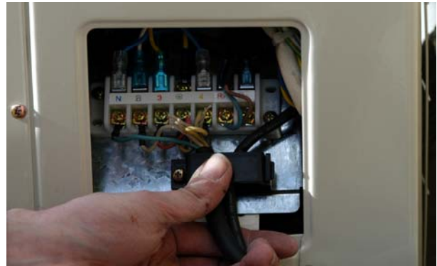
40. Monteer beide kabels onder de trekontlasting. Draai deze stevig vast.
