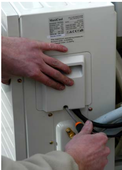
41. Monteer de electro-afdekplaat van de buiten-unit.
