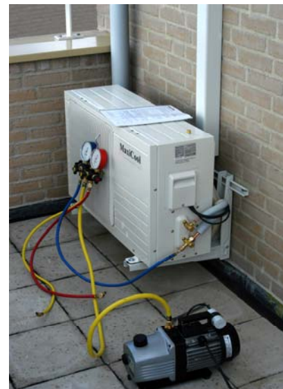
42. Het afmonteren en vacumeren van de installatie moet gebeuren door een erkend bedrijf. VRAAG UW LEVERANCIER VOOR INFORMATIE !!
