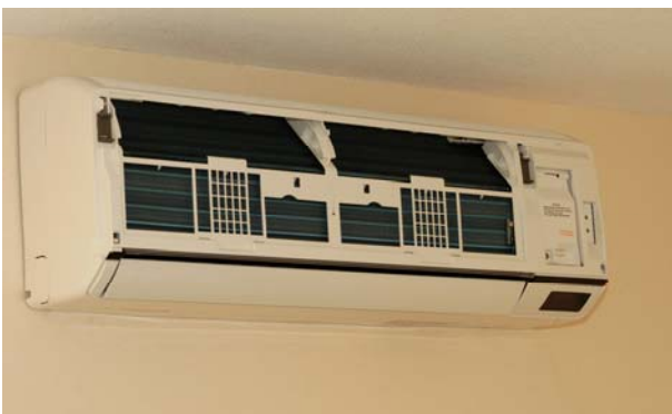
23. Duw de onderkant van de binnenunit tegen de muur totdat hij vastklikt. U bent nu voorlopig klaar met de binnen-unit.
