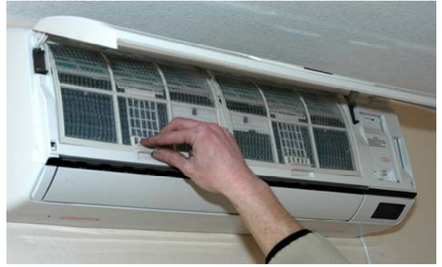
46. plaats de grote filters als laatste en monteer het frontpaneel.
