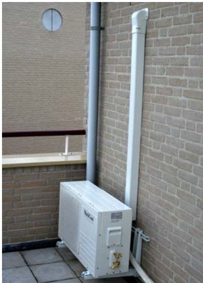
35. Monteer de streng met de bijgeleverde binders tegen de muur. Voor een fraaie afwerking kunt u het optioneel verkrijgbare gootsysteem gebruiken.
