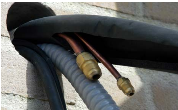
31. Begin nu meteen met de montage van de bijgeleverde koelleidingset. Is deze te kort raadpleeg dan uw leverancier.
