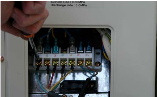
39. Monteer de elektokabels conform de kleurcodering op het paneel. De bruine ader van de signaalkabel aan de rechterzijde.
