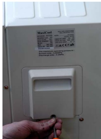
38. Verwijder de electro-afdeklaat van de buitenunit.
